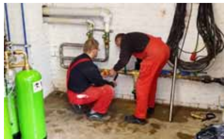
Einbau der Wasserenthärtungsanlage durch die Firma R.J. GmbH Sanitär Heizung und Fliesen
