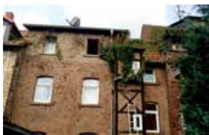
Hofansicht Löbstedter Straße 23 nach Freischneidung der Fassade
