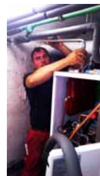
Einbau der neuen Heizung in der Mühlenstraße 17
